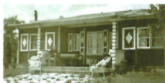
Das Alexanderhaus - Zustand vor 1938
