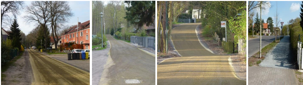
Es geht voran: 3 Straßen wurden im April neu befestigt – v. l. n. r.: die Straße Am Gutstor, die Landhausstraße, der Rehsprung bis zur Parzivalstraße. Auch befestigt wurde (rechts) der Gehweg am Nordende der Glienicker Dorfstraße. Die Befestigung endet an der Ampel, weil für die B 2 ein richtiger Straßenausbau vorbereitet wird.
